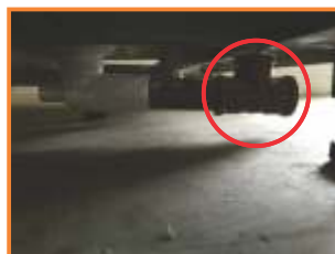
Saída de esgoto.
