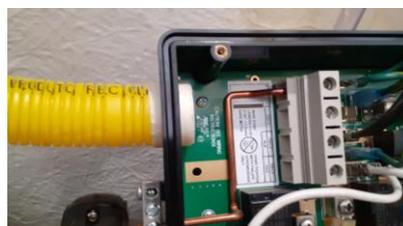
Se o diâmetro do eletroduto utilizado for diferente de 1 polegada, basta encaixar e fixar de maneira permanente na ponta de saída dos fios do eletroduto um trecho de aproximadamente 10 cm de conduíte flexível de 1 polegada, para que seja usado como ponteira de encaixe na entrada do quadro de comando e seguir as mesmas instruções anteriores.
