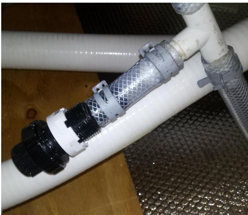
Com um alicate solte a braçadeira que prende a válvula (peça preta) na mangueira trançada e retire a válvula. Também retire o tapa-furo do painel de fechamento.
